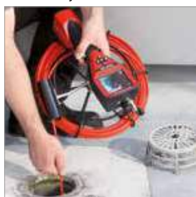
Inspekce potrubí pro svod dešťové vody
