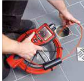
Inspekce podlahových odpadů
