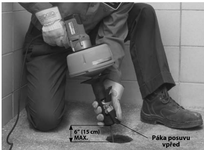
Obrázek 10 – Protlačení kabelu pomocí AUTOPOSUVU
